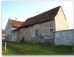
Château de Miécourt: façade nord des bâtiments. A remarquer: le contrefort qui soutient le bâtiment du rural. Février 2010. Photo JLM
