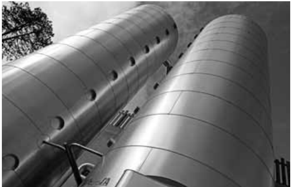
Les deux accumulateurs de 130 m3 d'eau à 90° C. Photo jlm
