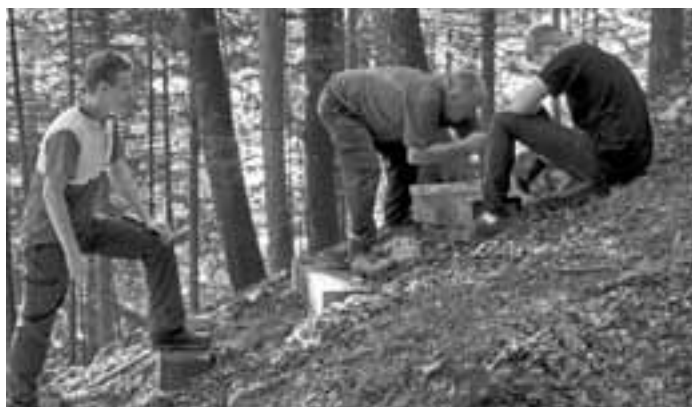
La mise d'aplomb et l'ancrage dans le sol des marches du sentier sont délicats. François Breton est à la manoeuvre. Photo ge
