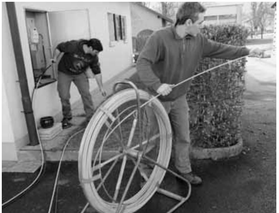
Fouilles à Courtedoux. A gauche, Cédric Donzé s'apprête à relier les câbles de l'armoire d'une maison-relai à celle qui est à l'arrière-plan. Le fil clair est un microtube vide. A droite, Mathieu Dominé rembobine la sonde qui a servi à tirer les câbles. Photo jlm
