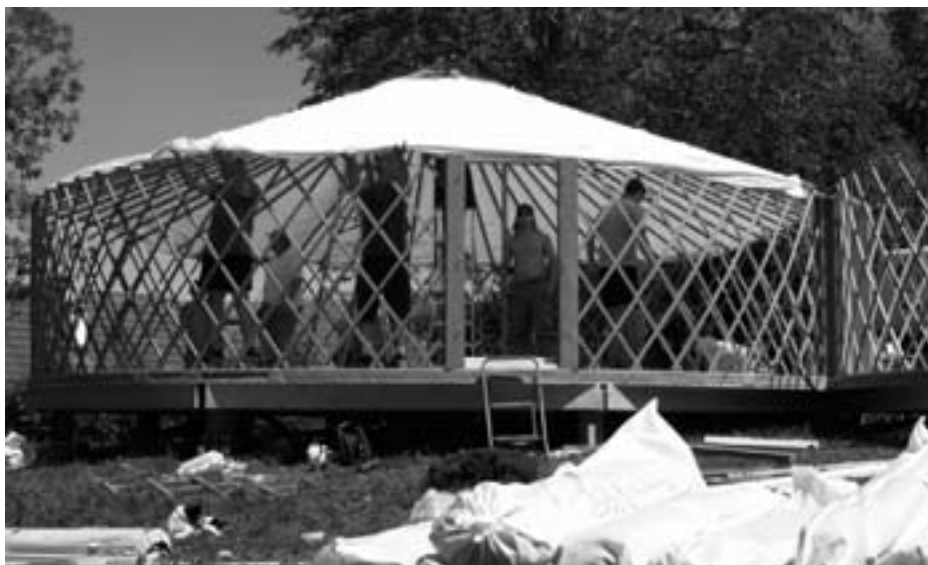
Le montage. Le treillis intérieur est monté; il faut désormais poser le voile blanc intérieur, pour permettre la luminosité intérieure.
