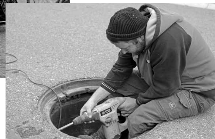
Martial Rich ci-dessus et Mathieu Grossenbacher ci-contre cassent le vieux béton d'une chambre, à Miécourt avant de procéder à un rhabillage. Tout Miécourt a été rafraîchi en 2018. En 2019, ce sera le tour des chambres de Charmoille. Photos jlm
