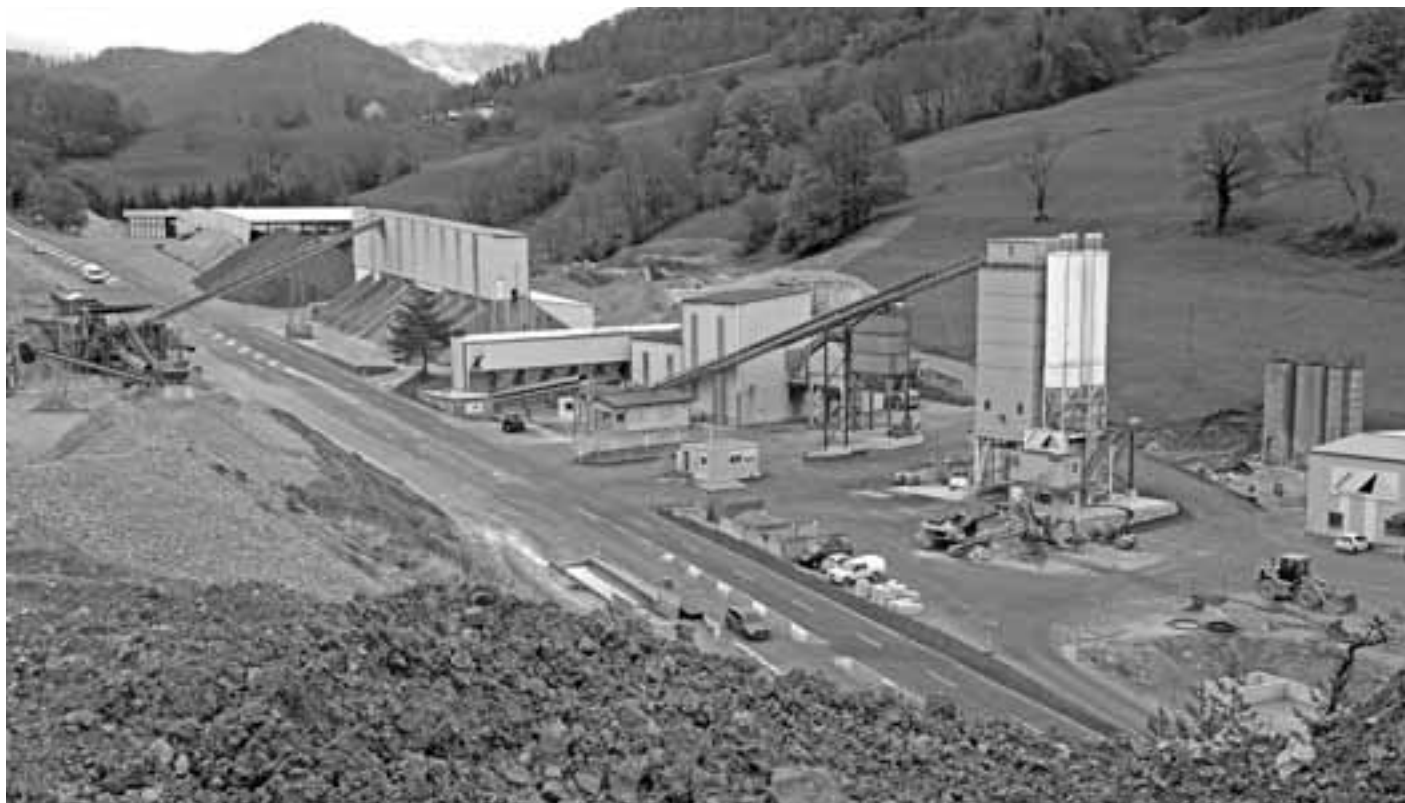
Vue générale du site de Lachat SA. A gauche, l'installation du triage primaire. De l'autre côté de la route, tri et concassage de sables et graviers de différentes granulométries. Au centre, production d'enrobés et de bétons. A droite, les silos à eau et les locaux d'entretien des machines. Photo jlm
