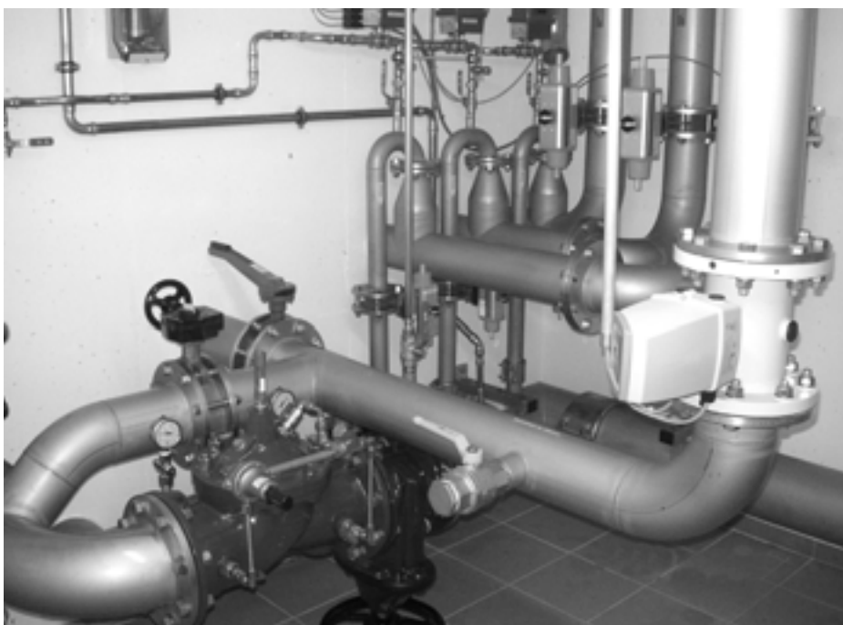
Le coeur de la distribution. Au centre-droit, les 3 petits tuyaux coudés, c'est l'arrivée des 3 sources avec, pour chacun, la sélection de la qualité. A droite, le grand tuyau qui coude en direction du mur est le départ au réservoir. Au premier plan: le réducteur de pression. Tout à gauche, la distribution vers Charmoille et Miécourt. Photo Patrick Houlmann.
