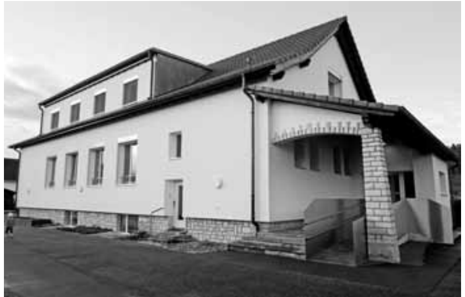
Le bâtiment de la maison de l'enfance à Miécourt a été assaini selon les normes Minergie, isolation intégrale. Photo jlm
