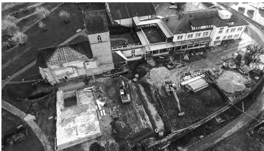
Installation de nouvelles conduites. Photo fg
