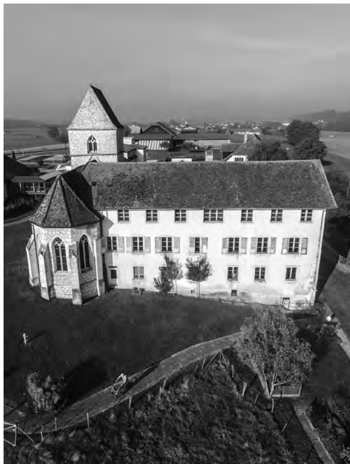
L'ancien bâtiment avant démolition. Photo fg
