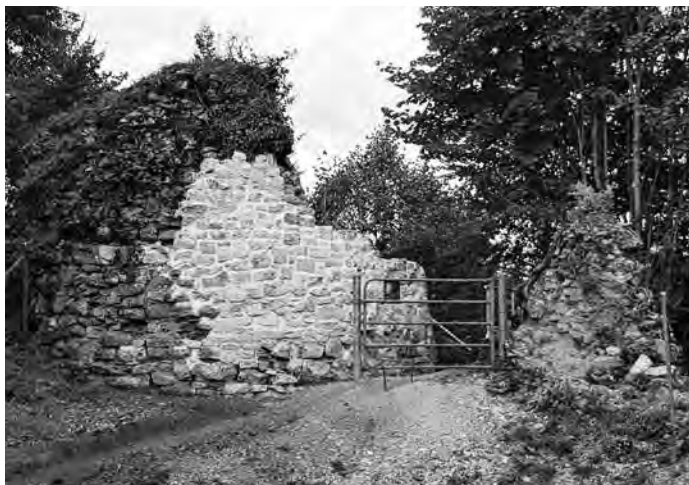
La consolidation du donjon est l'un des travaux réalisés par les bénévoles. Photo AACA
