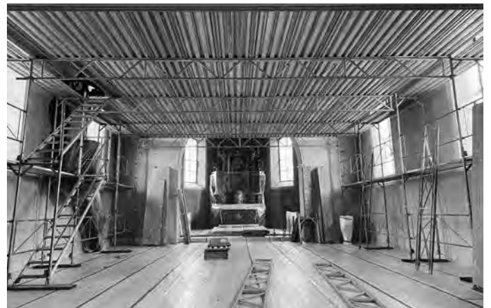
Le 22 janvier 2026, les travaux de peinture vont bon train. Photo ck
