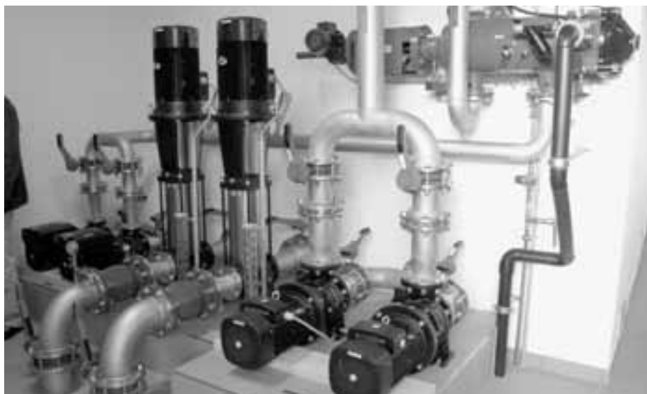
Les pompes de distribution (à gauche) et de traitement (à droite) du réservoir de Charmoille. En haut à droite, un préfiltre pour les grosses impuretés. Photo jlm
