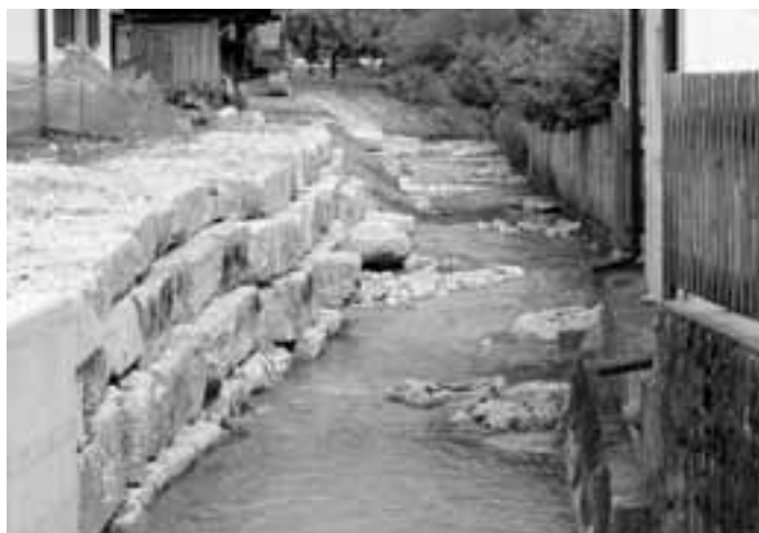
La berge droite est renforcée grâce à des blocs et des pierres disposées à droite et à gauche du lit en modérant le courant. Photo jlm
