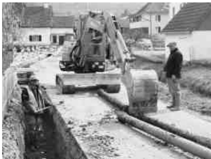
Place de l'école: on creuse d'abord une tranchée pour remplacer les anciennes canalisations – à droite sur la route. Photo jlm
