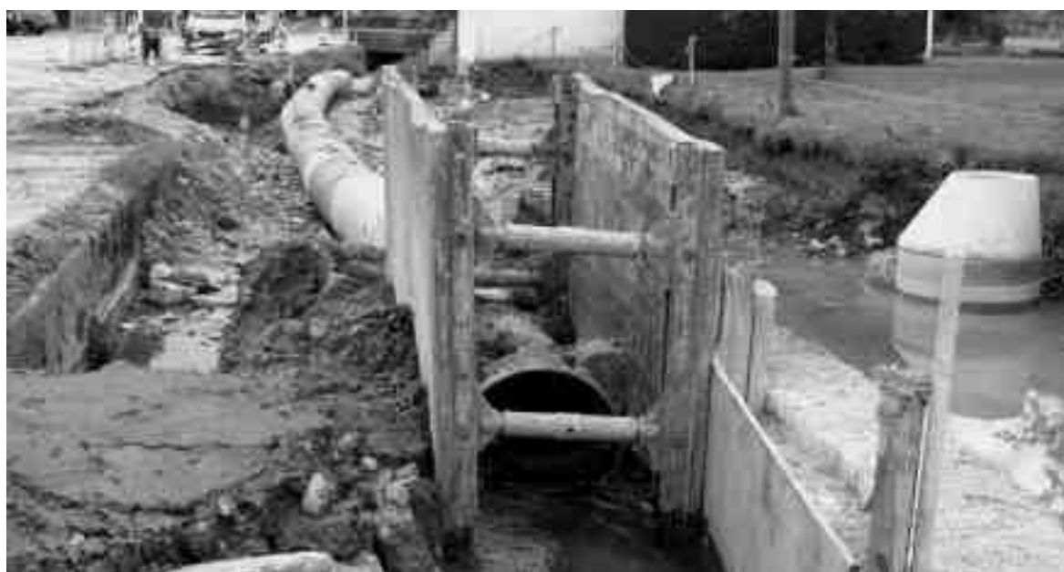
La rivière est canalisée dans un tuyau afin de permettre les travaux de maçonnerie. Photo jlm
