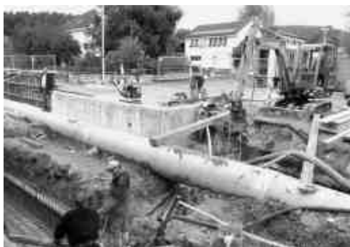
En haut, le mur est décoffré. On prépare déjà l'armature d'un autre mur (en bas). Le lit de la rivière est abaissé. Photo jlm
