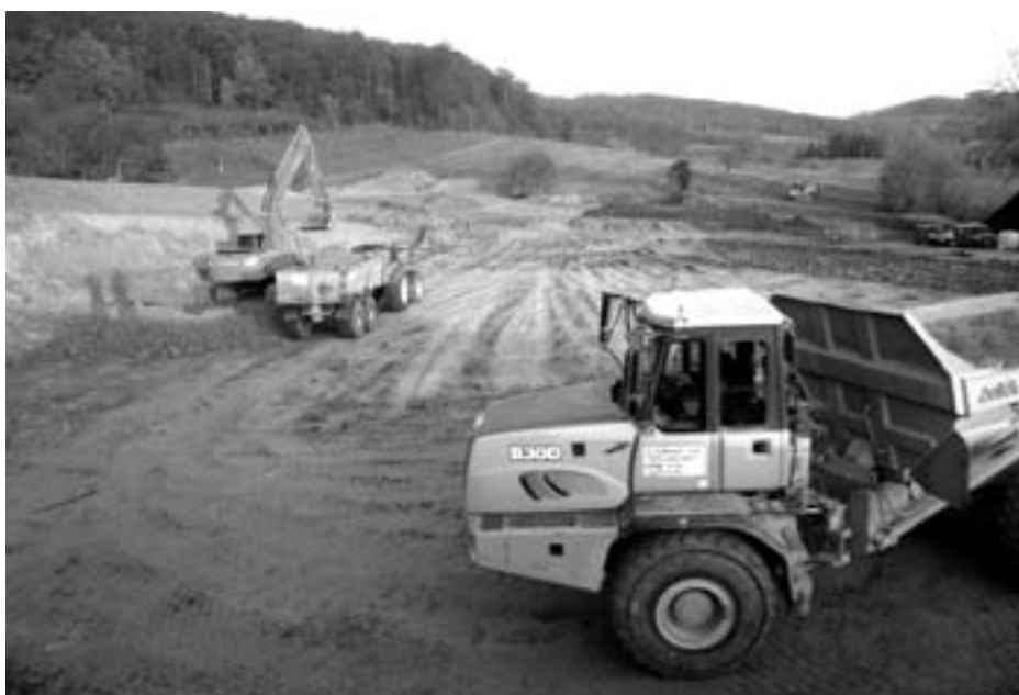
Chantier du hangar de Beausite, Charmoille. L'excavation est gigantesque. Des milliers de tonnes de terre servent à remblayer la combe proche de la ferme Nagel.
