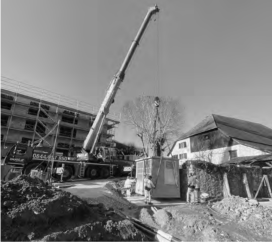
Mise en place d'un transformateur. Photo fn
