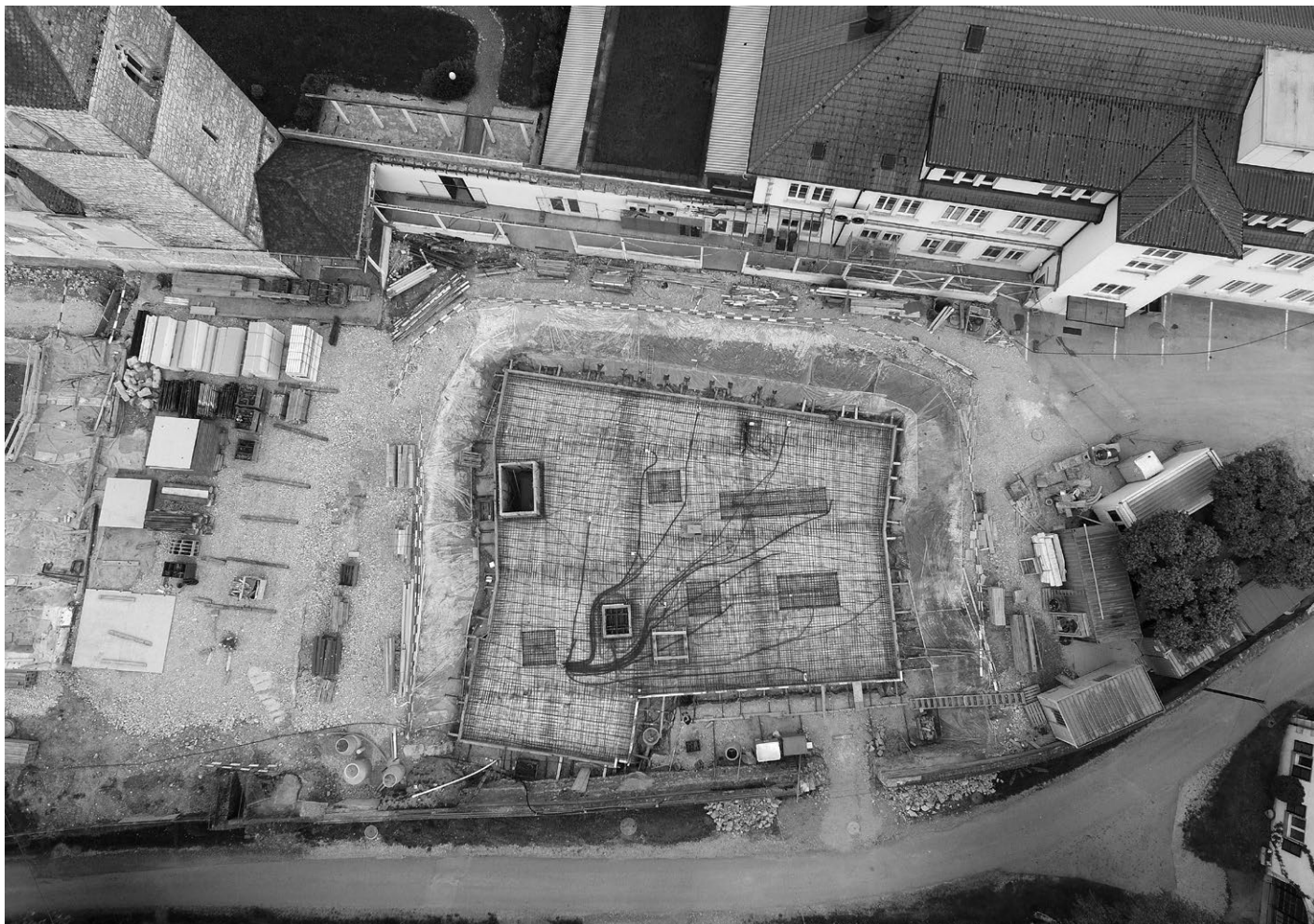
Coffrage et fer d'armature. Photo jpn
