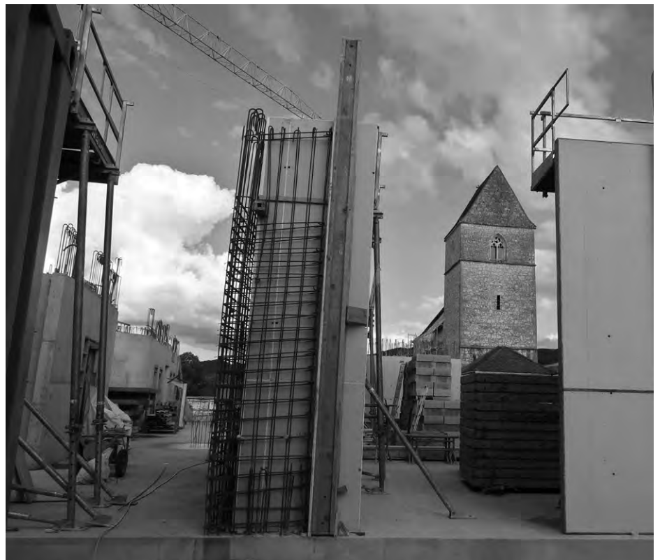
Les murs du rez-de-chaussée s'élèvent progressivement. Photos lm
