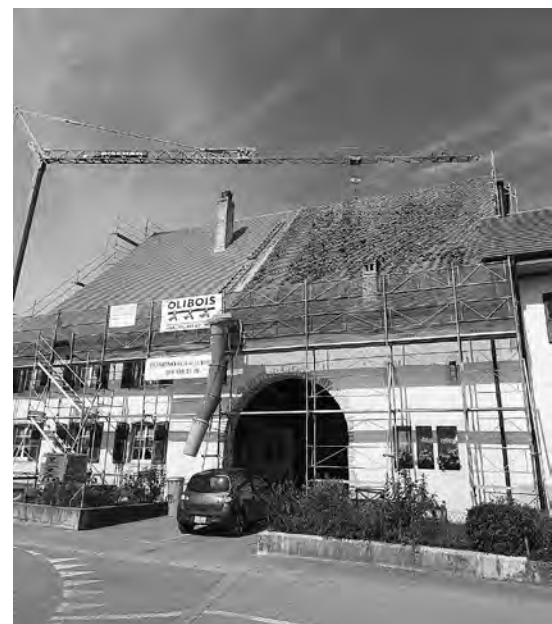
La maison de la dîme durant les travaux. Photo jp
