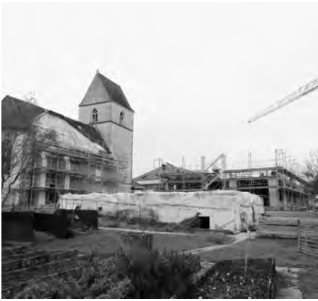
Le gros-œuvre devrait être terminé en mars 2023. Photo lm
