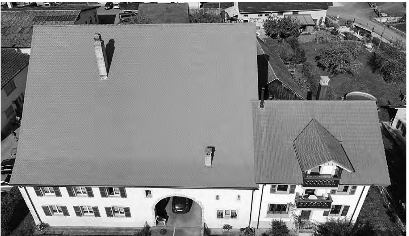
Le toit terminé. Photo gm
