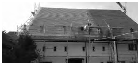
Nouveau toit pour la maison de la dîme 20
